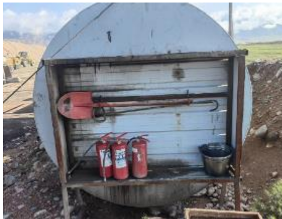
Рисунок 35: Укомплектованные пожарные щиты
