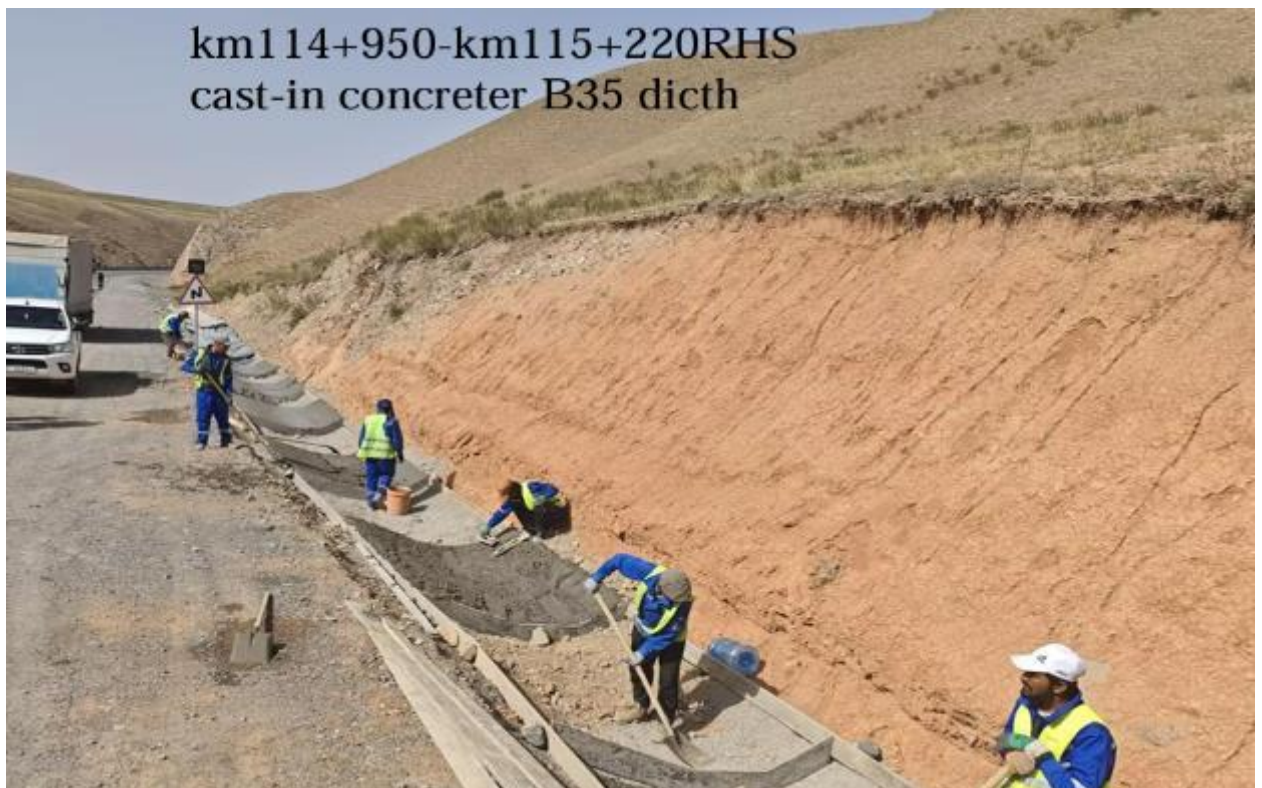
Рисунок 11: Устройство железобетонного водоотвода B35, км 114+950 – км 115+220, правая сторона.
