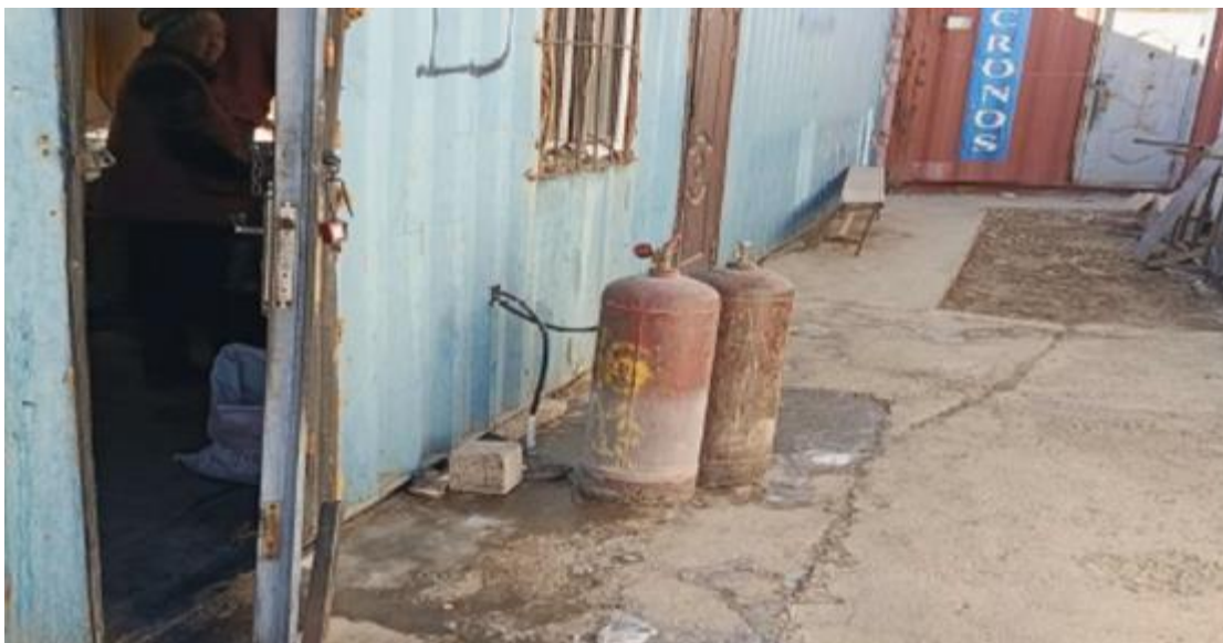
Рисунок 37: Нарушение правил хранения газовых баллонов
