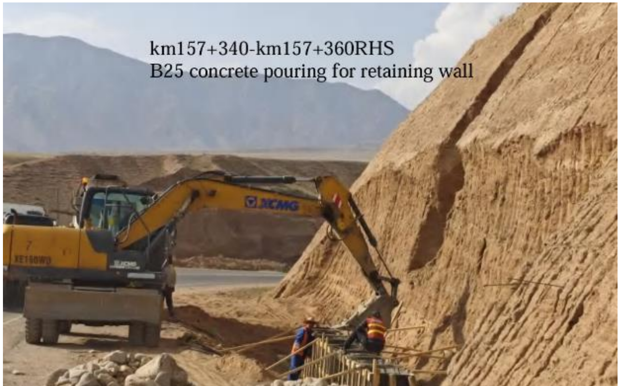
Рисунок 6: Заливка бетона В25 для подпорной стены, км 157+340 – км 157+360, правая сторона
