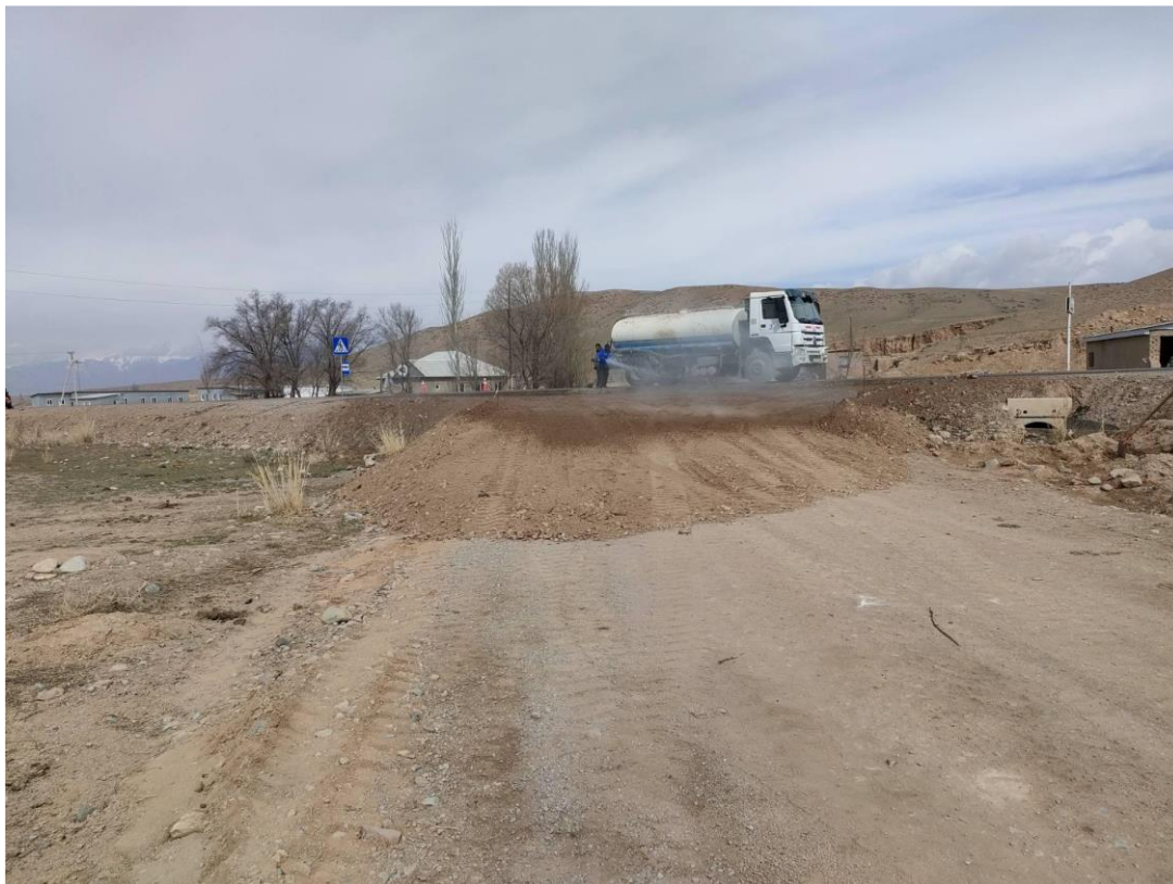
Рисунок 18: Пылеподавление при проведении земляных работ на перекрестке на км 137+062 (слева).
