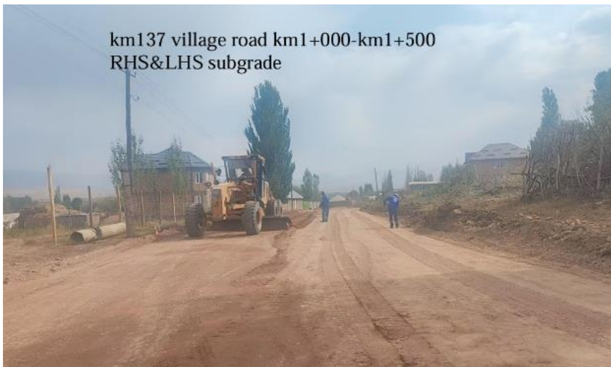
Рисунок 9: Устройство подстилающего слоя на участке км 1+000 – км 1+500 дополнительной местной дороги к с. Кызарт (км 137)
