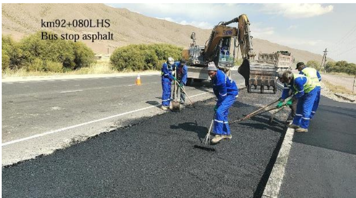
Рисунок 8: Асфальтирование автобусной остановки, км 92+080, левая сторона
