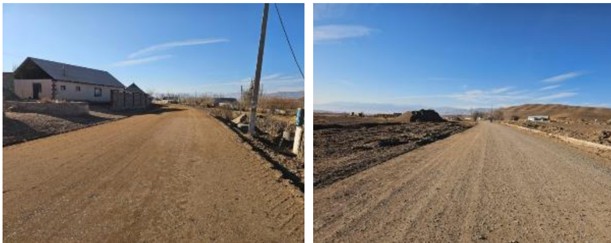
Рисунок 14: Подъездной путь к с. Кызарт от проектной автодороги Эпкин-Башкуганды (2,915 км)
