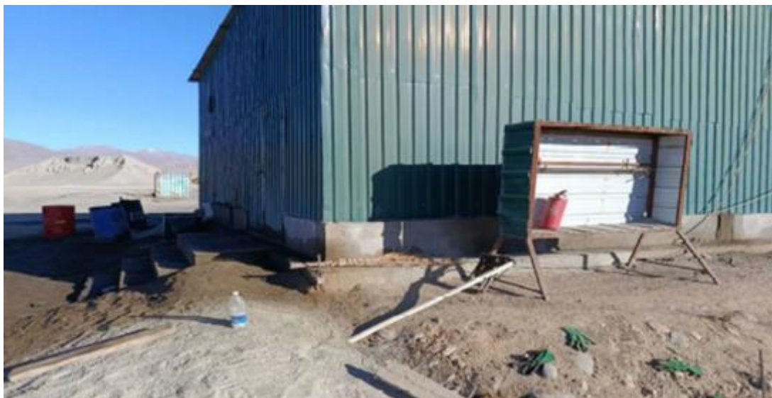
Рисунок 36: Неукомплектованность противопожарных щитов
