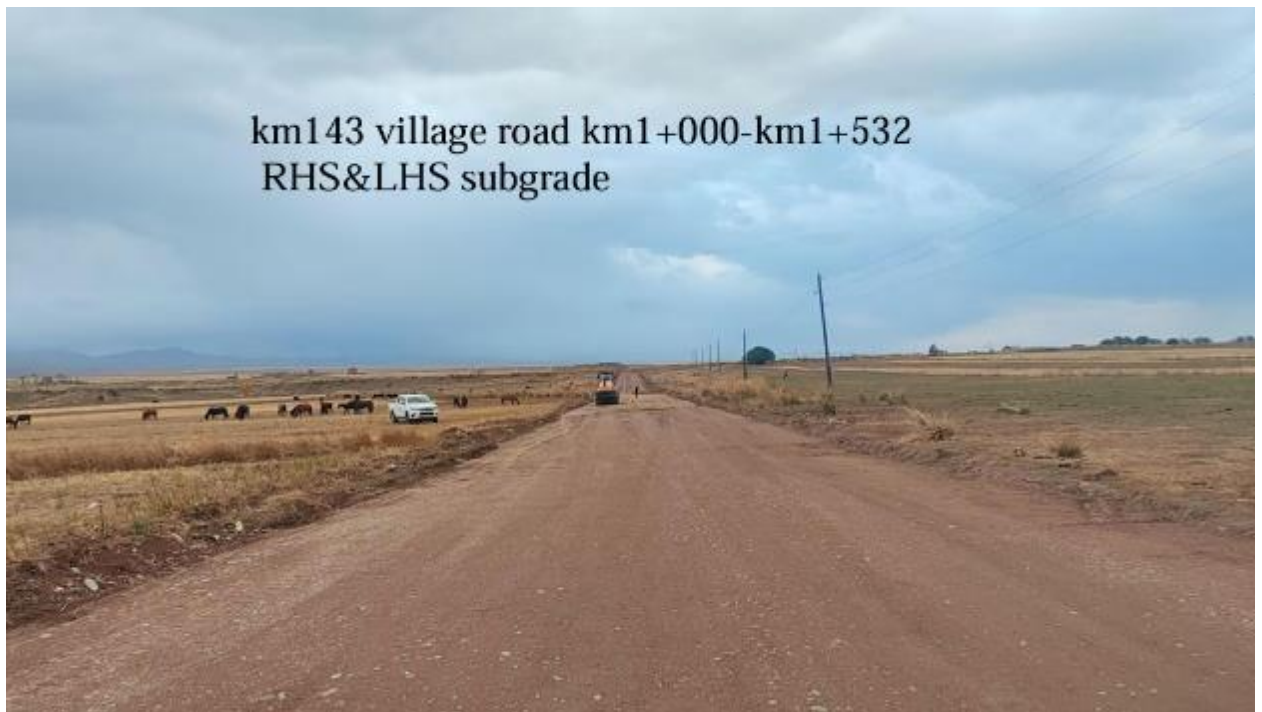
Рисунок 10: Устройство подстилающего слоя на участке км 1+000 – км 1+532 дополнительной местной дороги к с. Куйручук (км 143)
